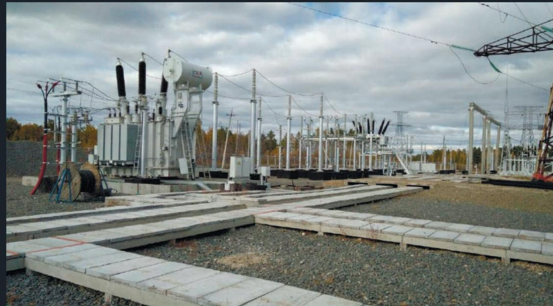
Наша компания выполнила проектные работы для нужд ОАО "Федеральная Сетевая Компания Единой Энергетической Системы". В ходе работ силовой трансформатор 220/35/10 кВ мощностью 20 МВА подстанции 220 кВ «Ключевая» был заменен агрегатом мощностью 25 МВА.
